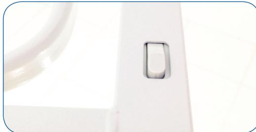
Fixação dos painéis com o sistema Easy-move
